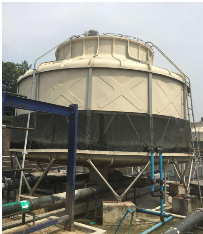
硝化池上的冷却塔
