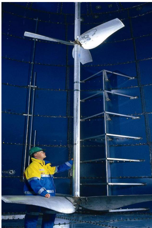
图1 厌氧发酵罐内部搅拌器叶轮
